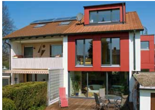
Um die Balkondecke und die alte Terrassendecke als Wärmebrücken unschädlich zu machen, wurde die gesamte Hausfront nach vorn versetzt.
