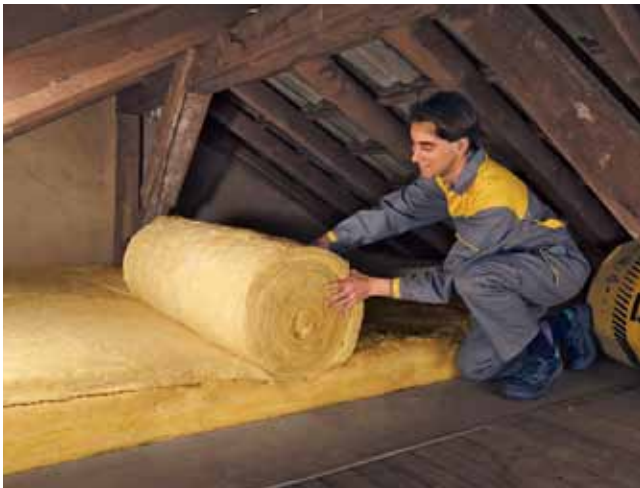
Ein unbeheizter Spitzboden braucht nicht gedämmt zu werden; wichtig ist aber eine dicke Dämmung des Fußbodens.
