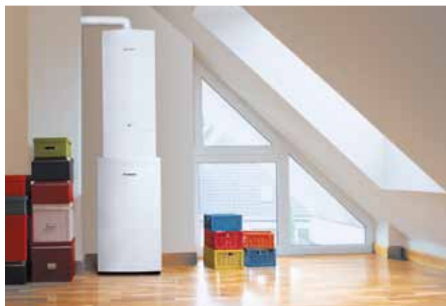
Brennwertkessel mit Warmwasserspeicher. Eine solche Heizungsanlage lässt sich durch die integrierte Bauweise und den raumluftunabhängigen Betrieb auch in der Wohnung aufstellen.
