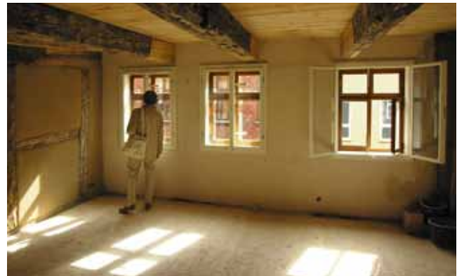
Bei der energetischen Modernisierung von Fachwerkhäusern ist Innendämmung heute allgemein üblich.
