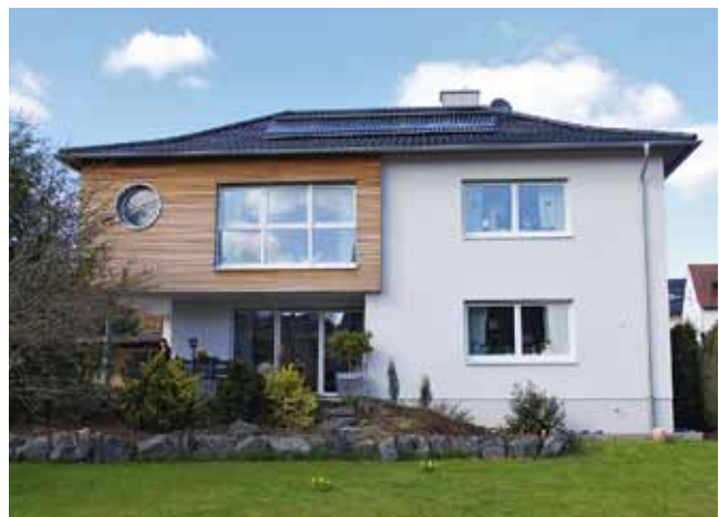
...sind nahtlos mit den Innendecken verbunden. Um diese starken Wärmebrücken zu beseitigen, wurde der Balkon vollständig umbaut und die Balkonplatte von unten dick gedämmt.
