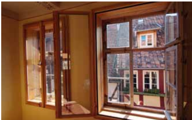
Die alten Sprossenfenster dieses Fachwerkhäuses wurden repariert und zu Kastenfenstern umgebaut.
