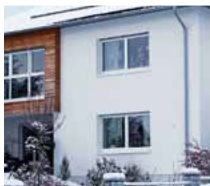
Dasselbe Haus mit gedämmter Fassade und Dreischeibenfenstern.
