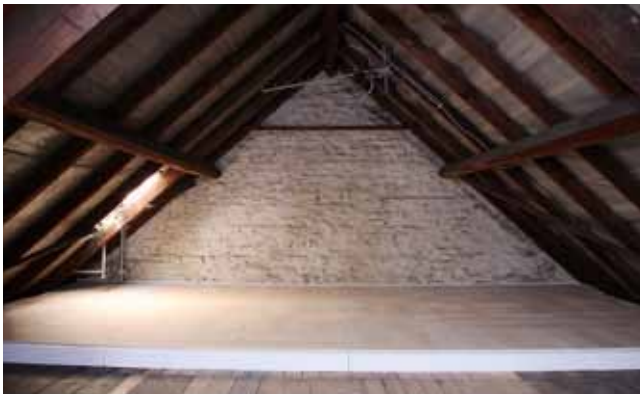
In allen historischen Gebäuden mit einem unbeheizten Dachboden lässt sich ohne Einschränkungen die Bodendecke dämmen.
