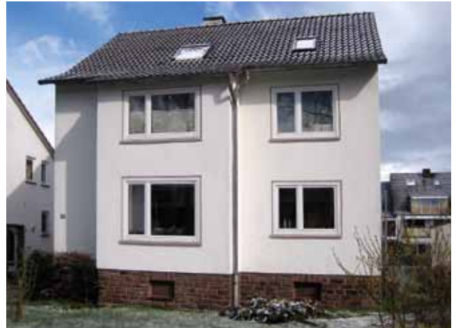
Fassadenvorsprünge wie bei diesem Haus erhöhen wegen ihrer Wirkung als zusätzliche geometrische Wärmebrücken das Sparpotenzial einer Außenwanddämmung.
