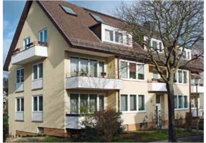
Mehrfamilienhaus von 1970 mit großen Isolierglasfenstern und -türen. Neue Dreischeibenfenster und gut gedämmte Türen hätten hier einen großen Spareffekt.
