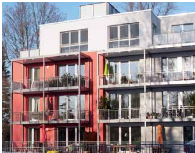
Passivhäuser wie dieses Mehrfamilienhaus sind durch eine dicke Dämmung und hochdämmende Dreischeibenfenster gegen Wärmeverluste perfekt geschützt.
