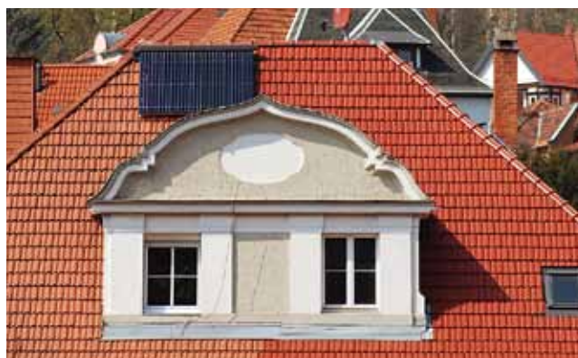
Der Solarkollektor ist hinter der Dachgaube installiert und so von der Straße aus nicht sichtbar.
