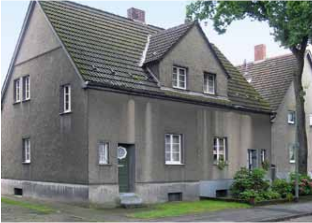
Zechensiedlungshaus von 1913 mit kleinen Fenstern. Hier wäre der Spareffekt von Dreischeibenfenstern gering, gleichwohl es sie auch als Sprossenfenster gibt.
