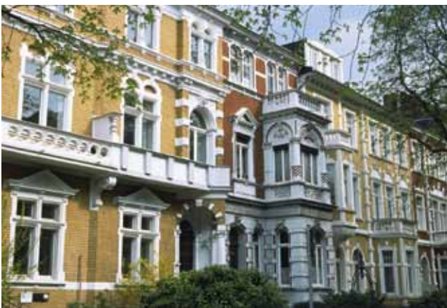
Für die energetische Modernisierung historischer Gebäude sind Konzepte gefragt, die das Erscheinungsbild des Hauses nicht beeinträchtigen.
