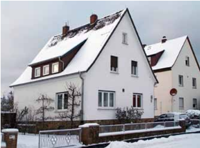
Freistehende ältere Ein- und Zweifamilienhäuser bergen wegen der großen Außenwandflächen hohe Einsparpotenziale für die Außenwanddämmung.
