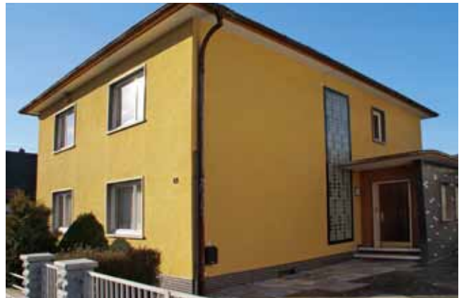
Glasbausteinwände und Bauteilanschlüsse zu unbeheizten Anbauten – wie hier der Eingangsvorbau – sind typische Wärmebrücken bei vielen Häusern aus der Zeit von 1960 bis 1980.
